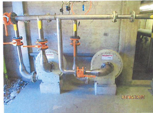
Foto 3 Bestehende Druckerhöhungsgebläse
